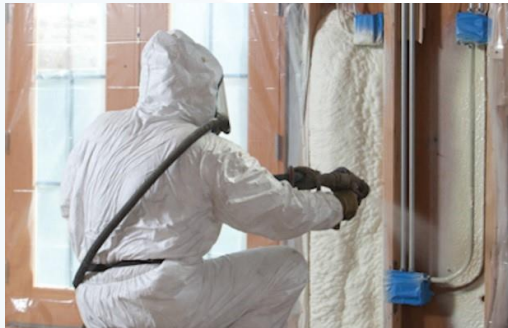
PU spray foam application
